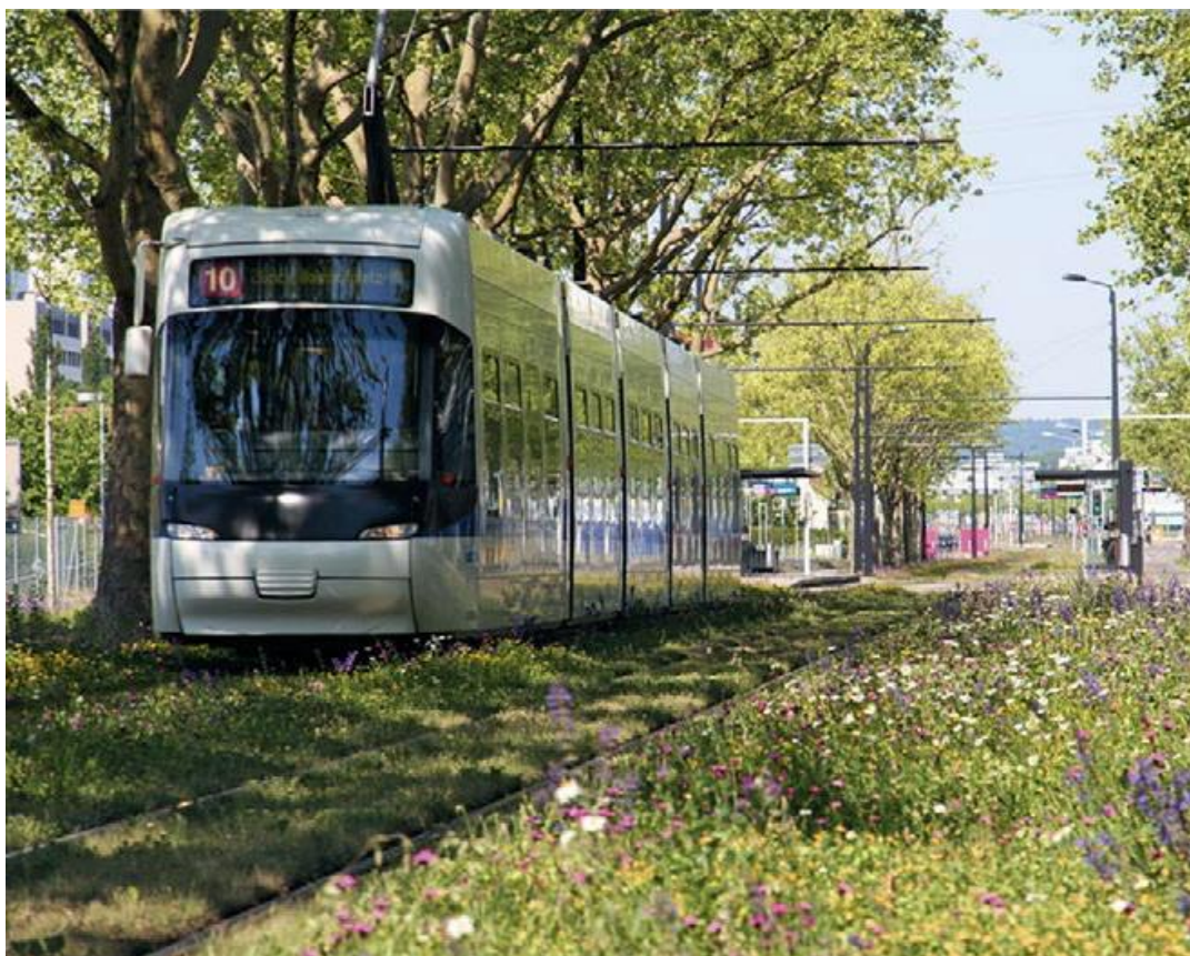
Le tracé de la Glattalbahn est végétalisé et ombragé par des arbres Source : OFEV, 2018, Quand la ville surchauffe, p. 55
